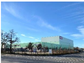
Foto 3: Wird ausgebaut: Das Zentrale Ersatzteillager an der Edisonstraße/Stadtring Nordhorn. (Foto: Miele)
